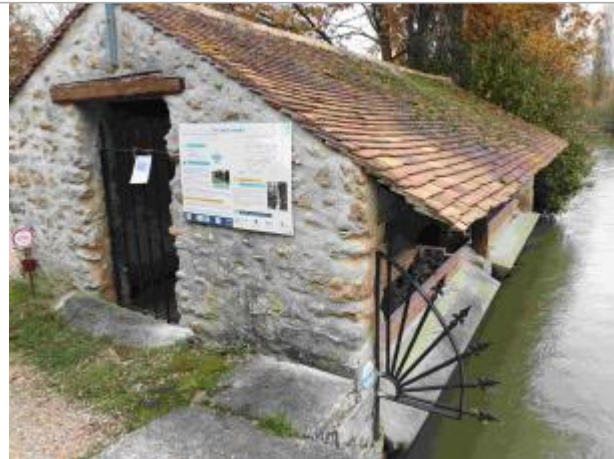
Repère de crue du 31 mai 2016 de la Rèmearde à Breuillet
