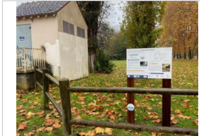
Repère de crue du 12 juin 2018 du Montabé à Saint Rémy lès Chevreuse
