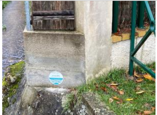
Repère de crue du 31 mai 2016 du ru du Feu Saint Jean
