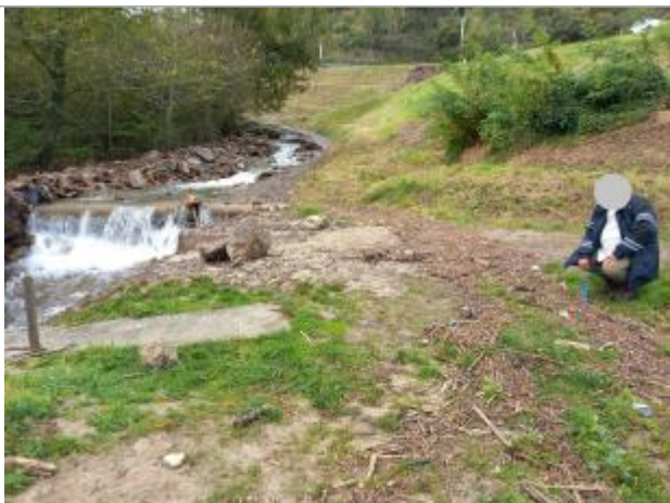
Vue rapprochée de la laisse de crue, auteur : DDT 42, prise de vue du 22/10/2024
