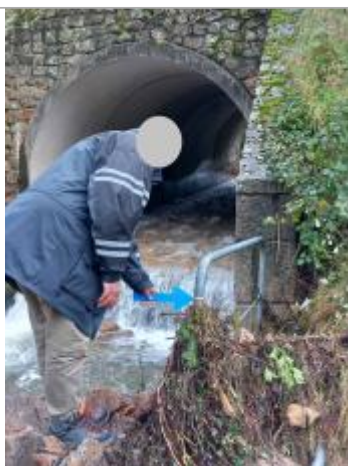
Vue rapprochée de la laisse de crue, auteur : DDT 42, prise de vue du 22/10/2024
