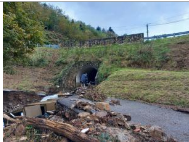
Vue générale du site, auteur DDT 42, prise de vue du 22/10/2024
