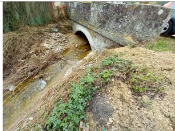
Vue générale du site, auteur DDT 42, prise de vue du 31/10/2024
