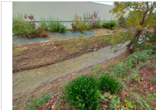
Vue générale du site, auteur DDT 42, prise de vue du 31/10/2024
