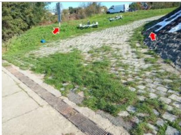
Vue du repère en 2024 (source : DDT42)
