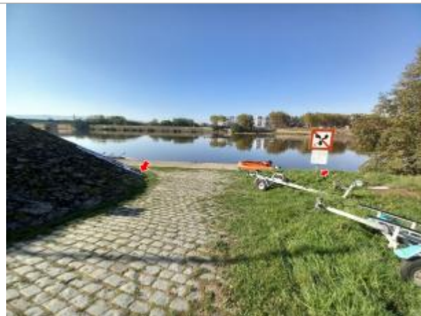
Vue du site en 2024 (source : DDT42)
