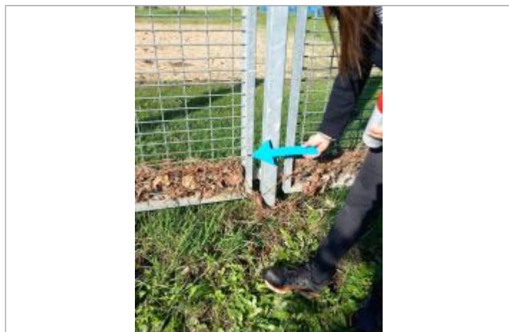
Vue rapprochée du repère en 2024 (source : DDT42)
