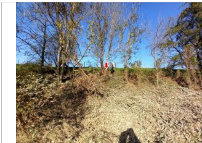
Vue du site en 2024 (source : DDT42)
