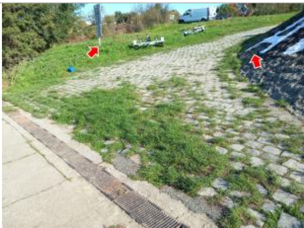
Vue du repère en 2024 (source : DDT42)
