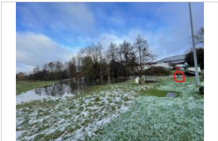
Les tuyaux d'assainissement, situés dans la rivière en aval du pont, et habituellement hors d'eau ont été légèrement submergés
