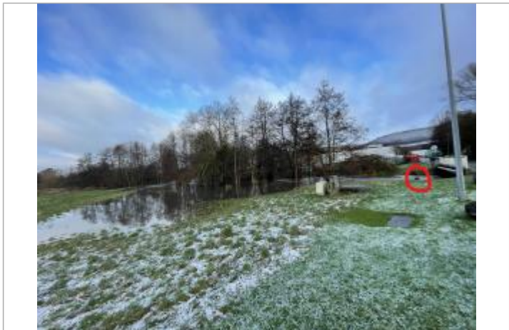
Les tuyaux d'assainissement, situés dans la rivière en aval du pont, et habituellement hors d'eau ont été légèrement submergés
