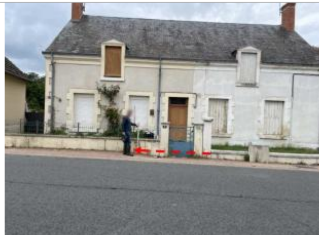
Vue du site en 2025 avec le repère de la crue de mai 2016 (source : DH&amp;E)
