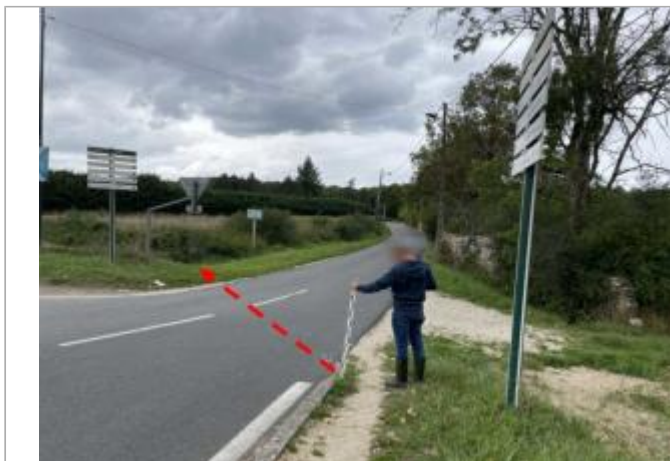
Vue du site en 2025 et repère de la crue de mai 2016 (source : DH&amp;E)
