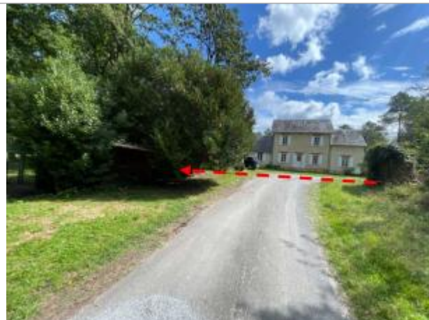
Vue du site en 2025 avec le niveau atteint par la crue de mai 2016 (source : DH&amp;E)
