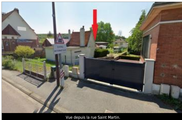
Vue depuis la rue Saint Martin.
