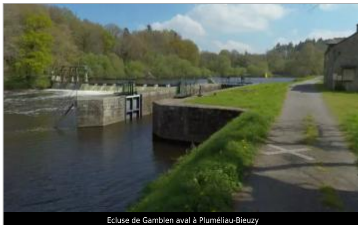
Ecluse de Gamblen aval à Plumélieu-Bieuzy
