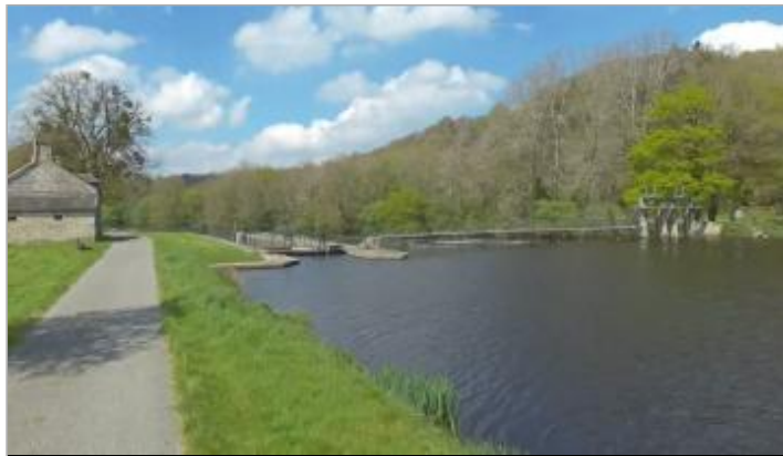
Ecluse de Gamblen amont à Pluméliau-Bieuzy
