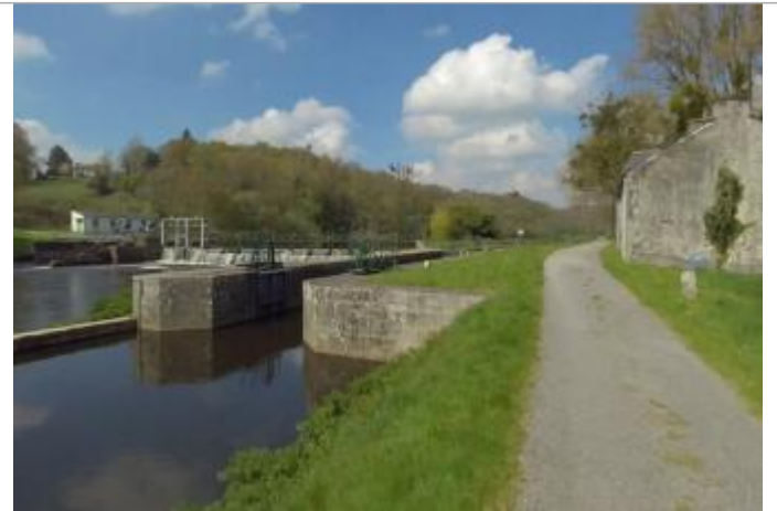
Ecluse de Moulin Neuf aval à Pluméliau-Bieuzy
