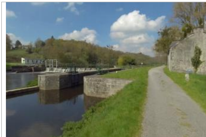
Ecluse de Moulin Neuf aval à Pluméliau-Bieuzy
