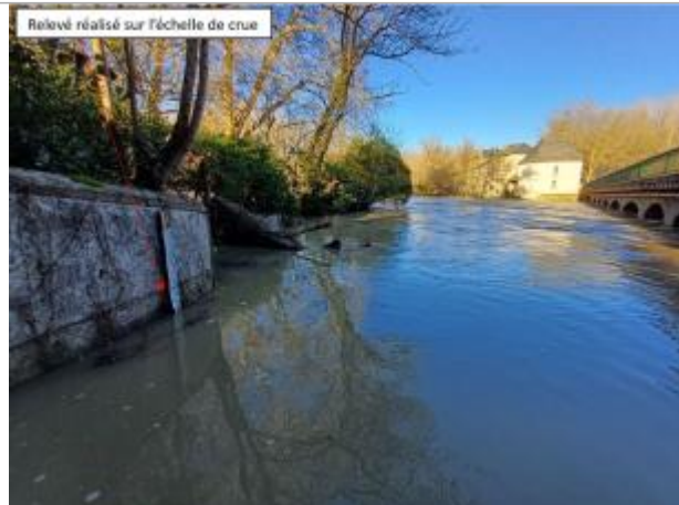
Vue du site le 13/01/2025 (source : SAVI 37)
