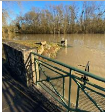
Vue du site le 13/01/2025 (source : SAVI 37)
