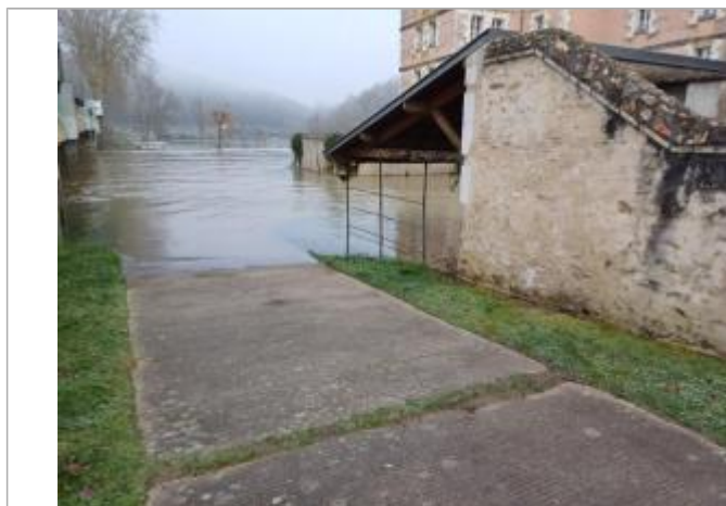
Vue du repère le 15/01/2025 à 10h50 (source : SAVI 37)
