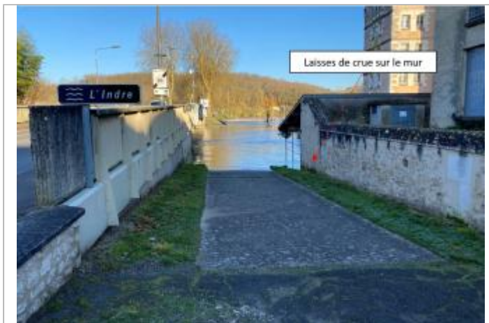
Vue du site le 13/01/2025 (source : SAVI 37)
