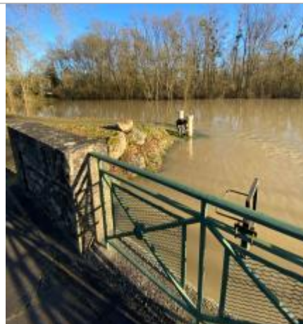
Vue du site le 13/01/2025 (source : SAVI 37)
