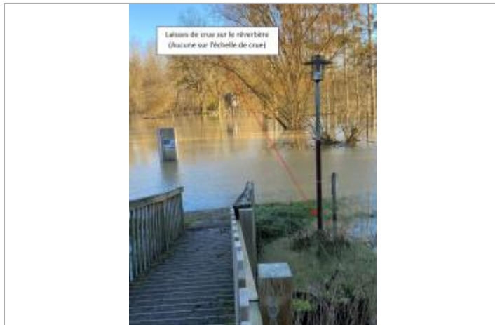
Vue du site le 13/01/2025 (source : SAVI 37)
