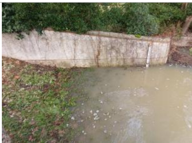
Vue du repère le 15/01/2025 à 11h45 (source : SAVI 37)
