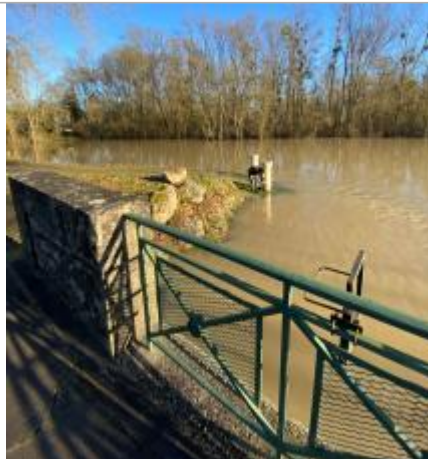
Vue du site le 13/01/2025 (source : SAVI 37)
