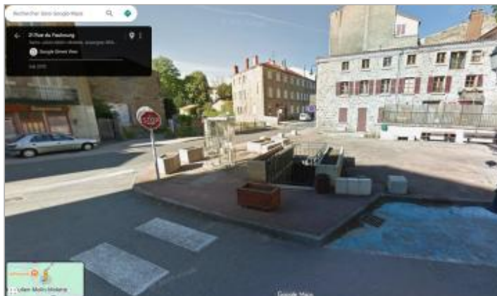
Escalier d'accès au Ternay, rue du Faubourg (photo Google Street)
