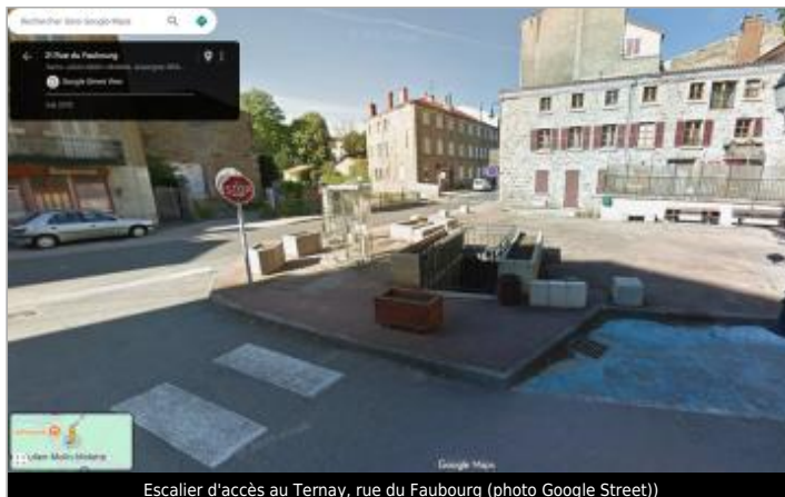
Escalier d'accès au Ternay, rue du Faubourg (photo Google Street)
