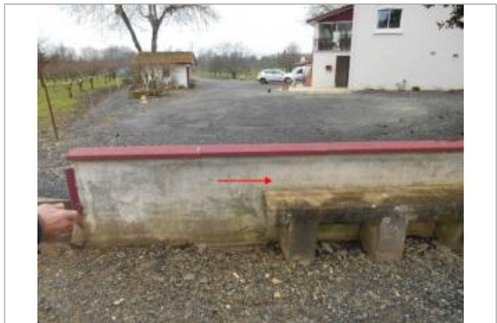
Vue du site et du repère - auteur : Artelia
