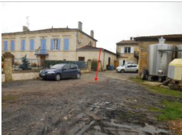
Vue du site et du repère - auteur : Artelia
