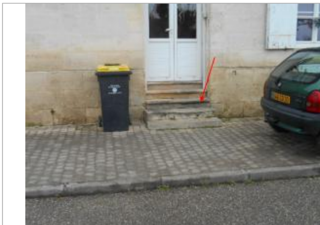
Vue du site et du repère - auteur : Artelia
