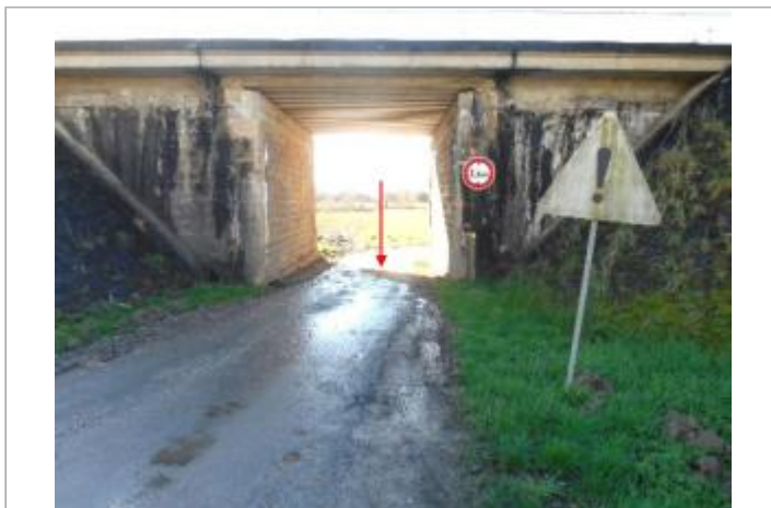
Vue du site et du repère - auteur : Artelia
