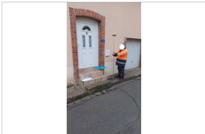
laisse de crue à 45 cm/sol.
