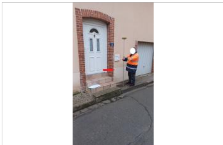
Laisse de crue à 51 cm/sol.
