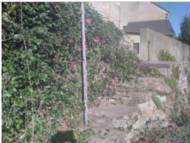
Vue du repère en octobre 2024
