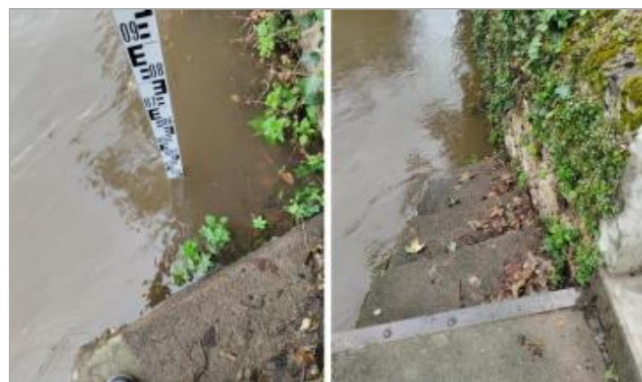
Vue du repère lors de la crue
