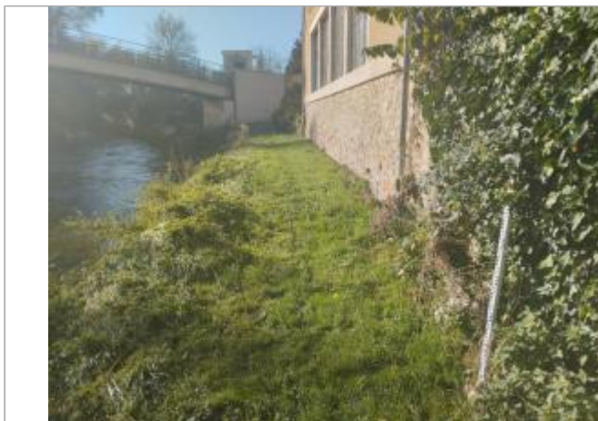
Vue du site en octobre 2024
