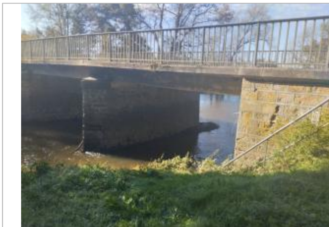
Vue du site en octobre 2024
