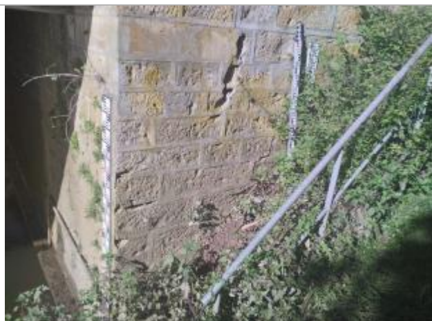
Vue du repère en octobre 2024
