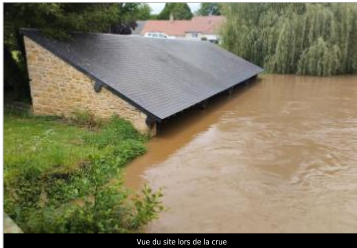
Vue du site lors de la crue
