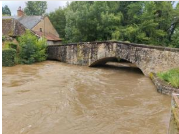
Vue du site lors de la crue
