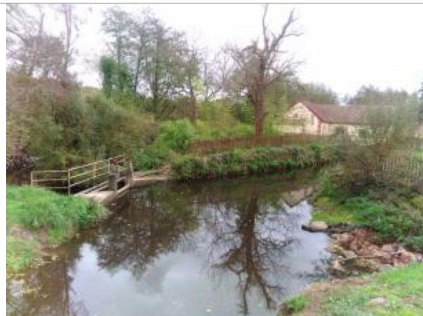
Vue du site en novembre 2025
