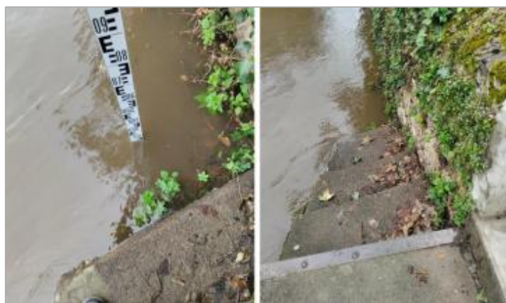
Vue du repère lors de la crue
