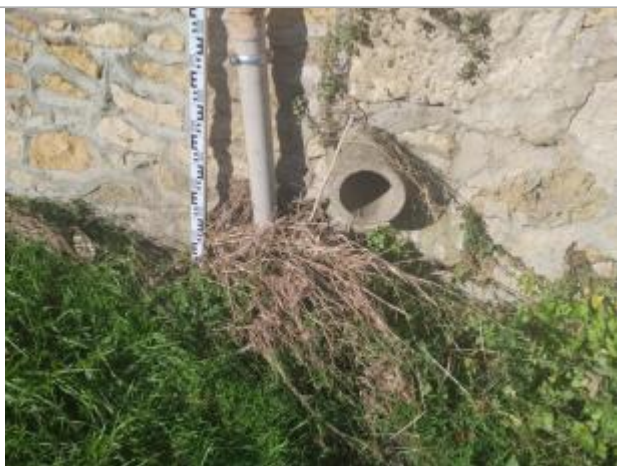
Vue du repère en octobre 2024
