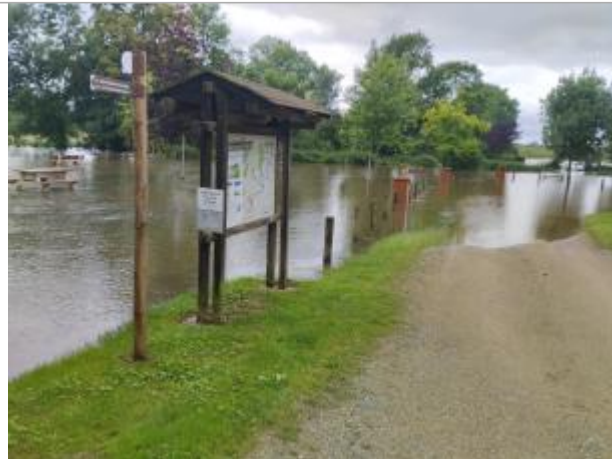
Vue du site lors de la crue
