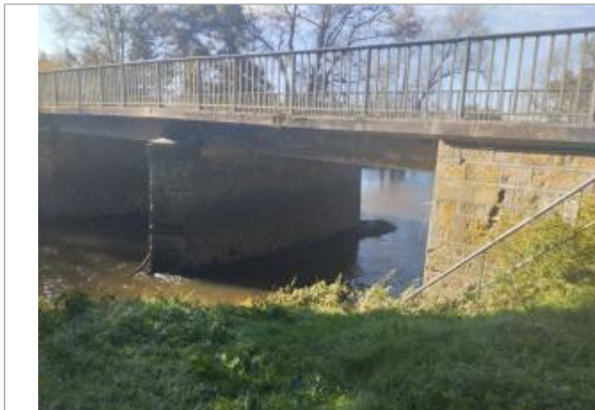
Vue du site en octobre 2024
