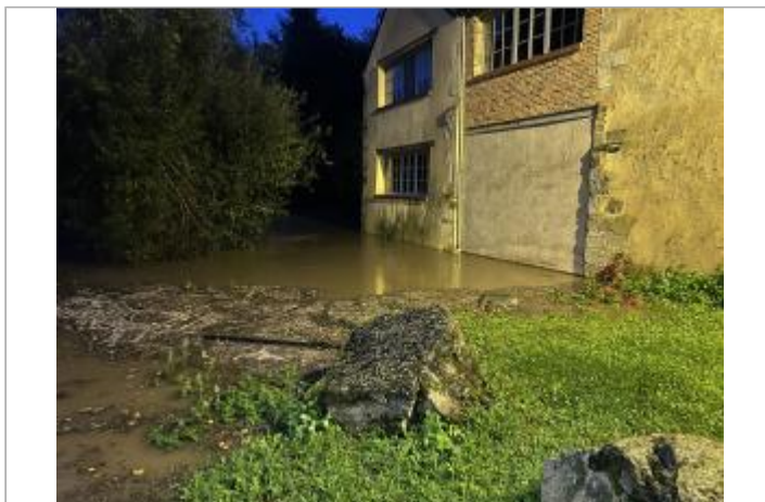
Vue du site lors de la crue
