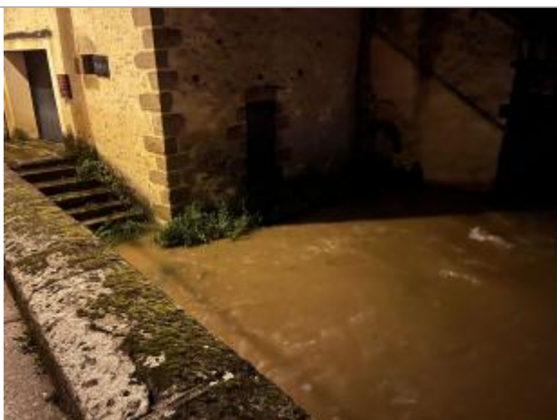
Vue du repère lors de la crue
