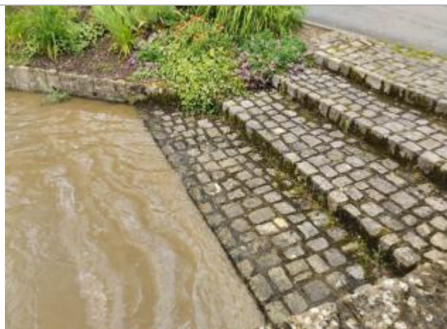
Vue du repère lors de la crue
