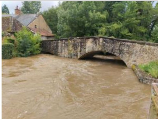
Vue du site lors de la crue
