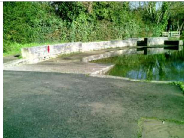
Vue générale du site
